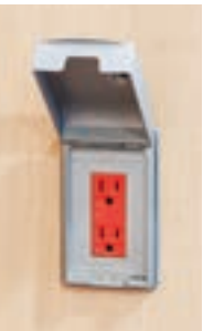
非常用コンセント （参考写真）
