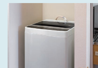
洗濯機スペース
