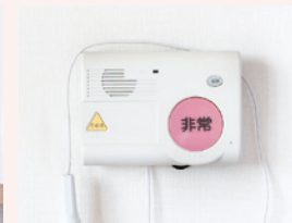
緊急通報装置
