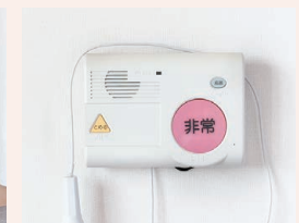
緊急通報装置
