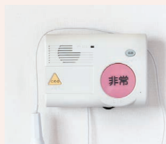
緊急通報装置
