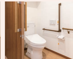
緊急通報装置がある安全なトイレ
