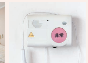
緊急通報装置
